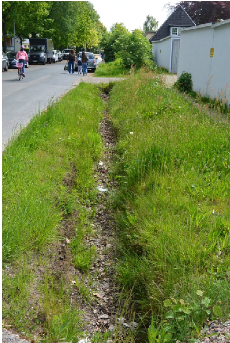
Foto 1: Rennplatzstraße: Straßenseitengraben mit Überfahrten zu den Bestandsgaragen (Stand 2024)
