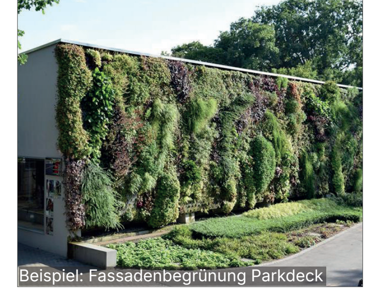
Beispiel: Fassadenbegrünung Parkdeck
