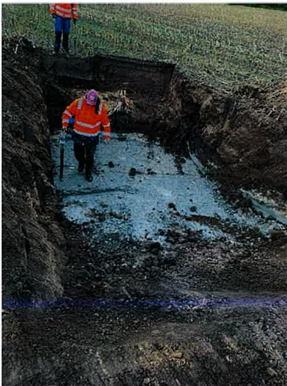
Sondierung nach Freiräumung des Schutts
