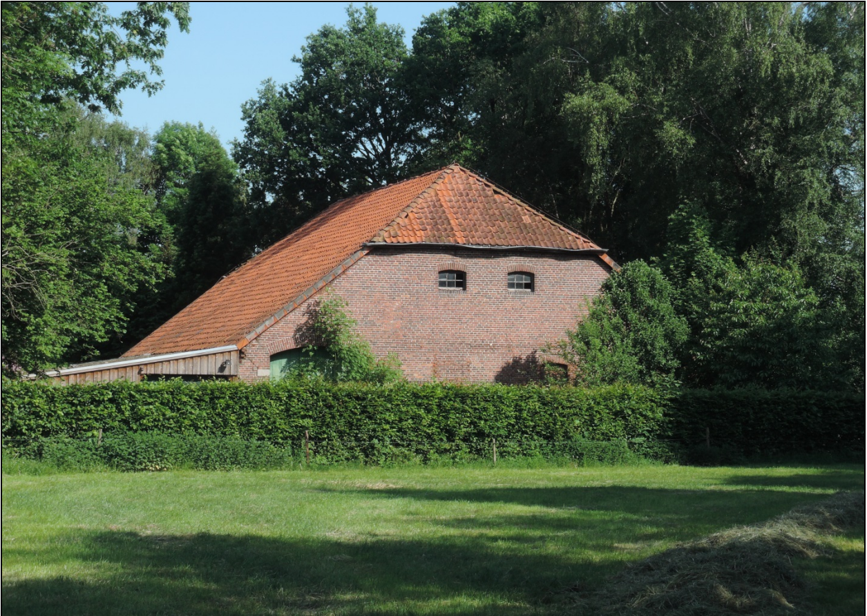
Abb. 4: Blick auf die ehemalige Hofstelle (23.05.2018).
