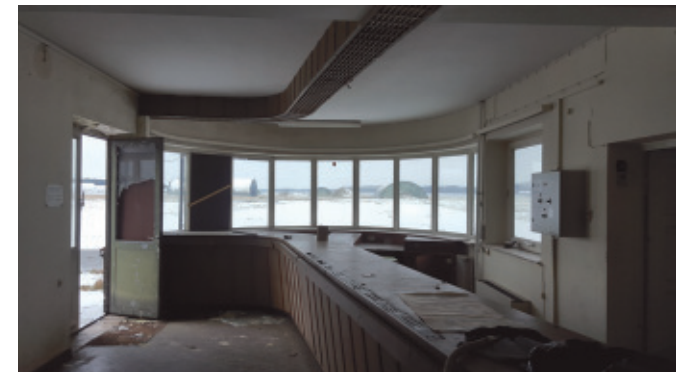
Eingangstresen im Erdgeschoss
