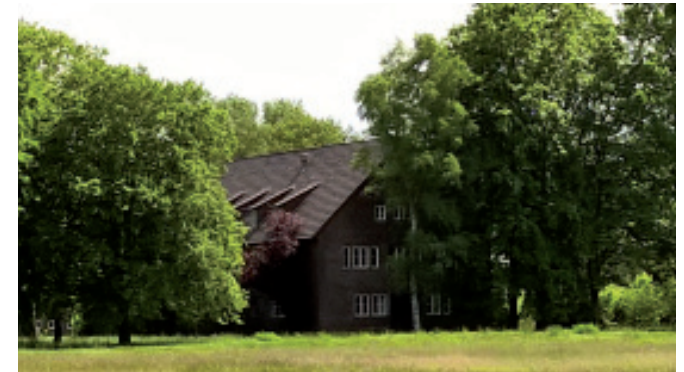
Unterkunftsgebäude von Norden gesehen
