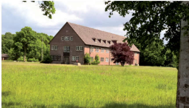
Stabsgebäude von Norden gesehen
