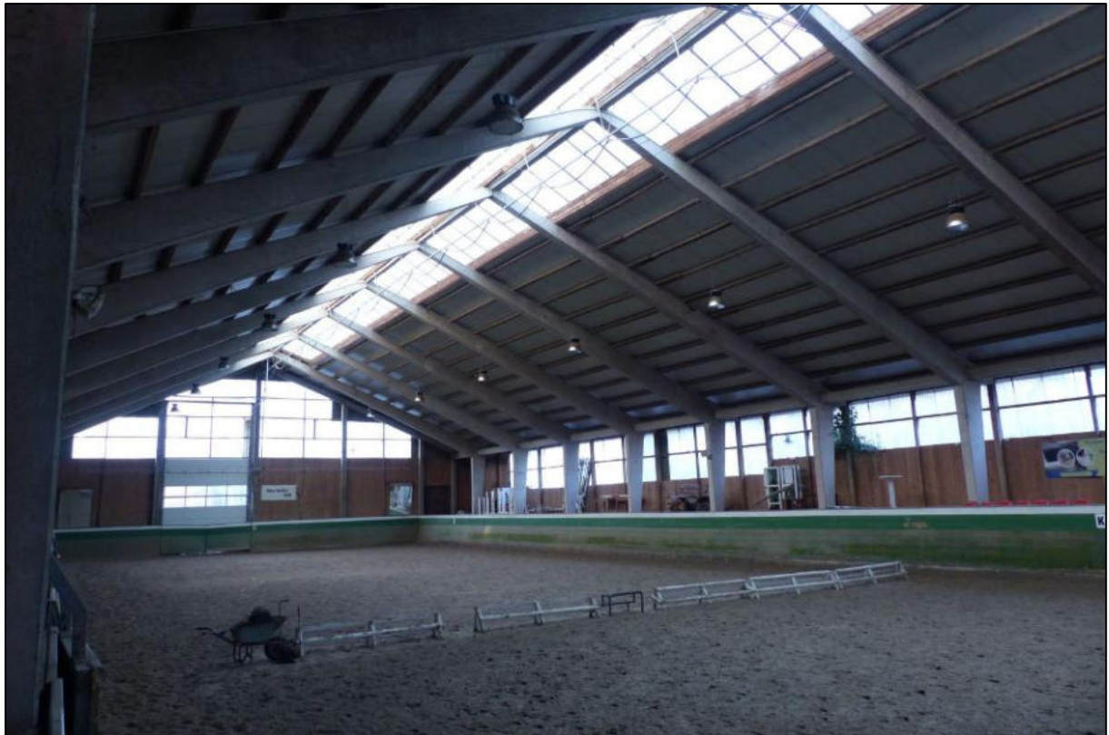
Abb. 5: Die Reithalle von innen, die Außenwände sind in großen Teilen mit Holzverschalung von innen verkleidet
