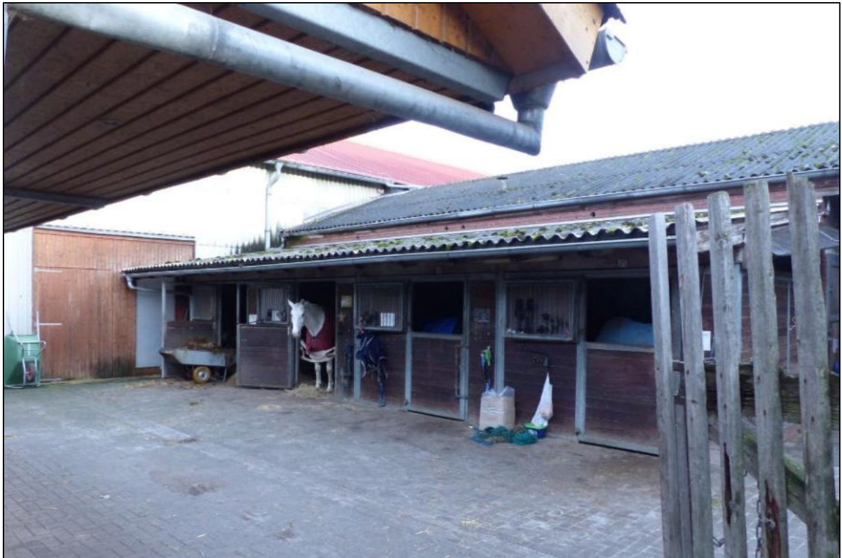
Abb. 11: Außenboxen mit gepflastertem Boden, Gebäudeteil Nr. 4 in Abb. 13
