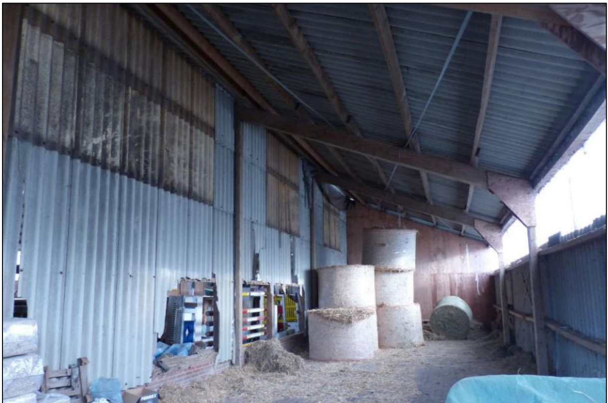
Abb. 12: Halboffenes Heulager (Gebäude Nr. 6 in Abb. 13) direkt angrenzend an die Reithalle, große Öffnungen zur Reithalle in der Eternitwand (linke Bildhälfte)
