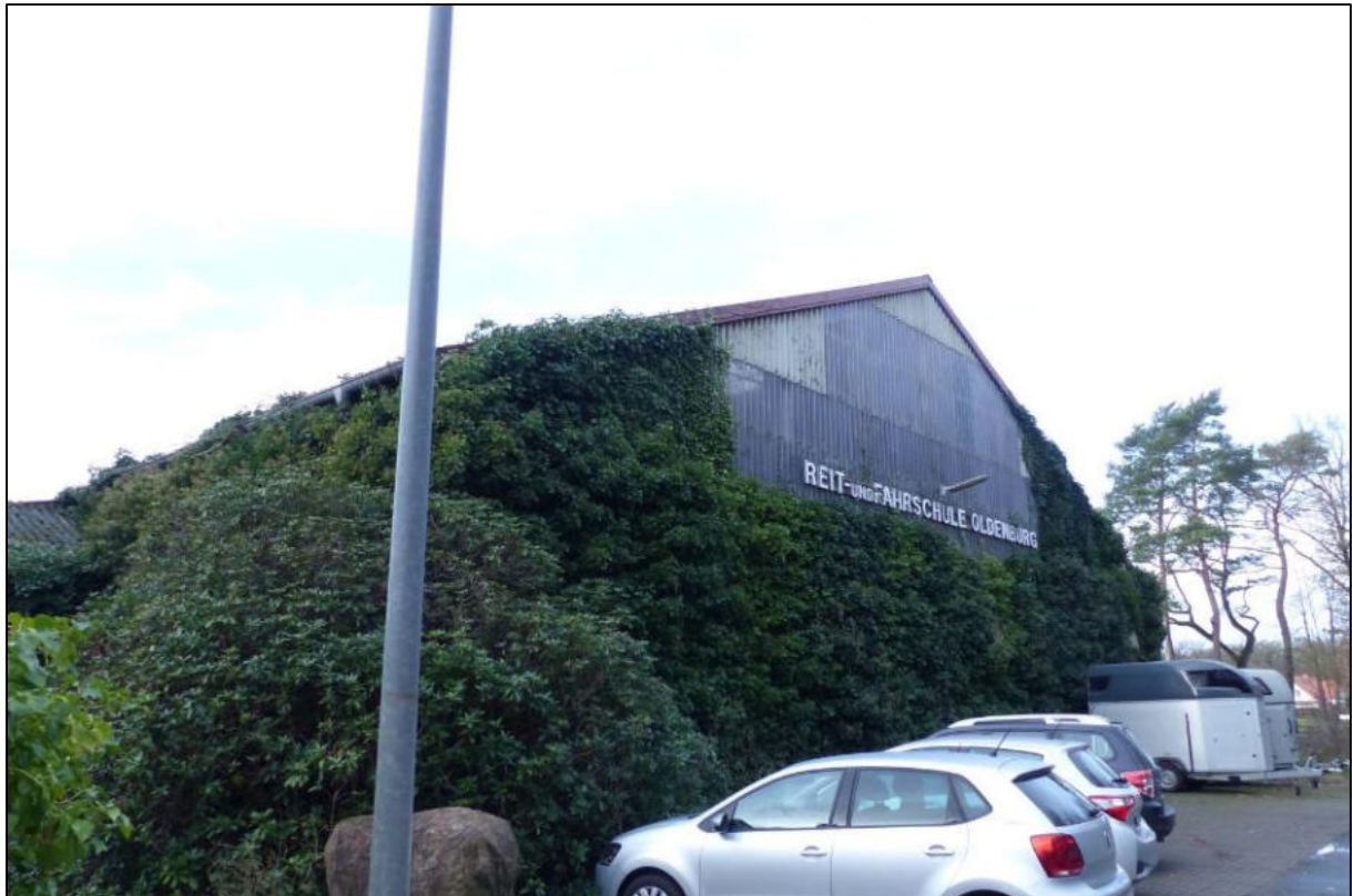
Abb. 9: Östliche Giebelseite der Reithalle (Gebäude Nr. 1 in Abb. 13) mit Efeubewuchs, Rhododendron und Parkplatz
