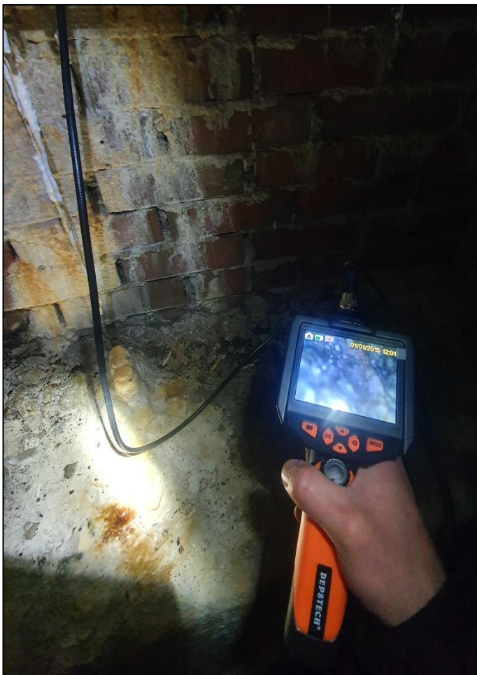
Abbildung 4: Einsatz des Endoskops im Rundbunker
