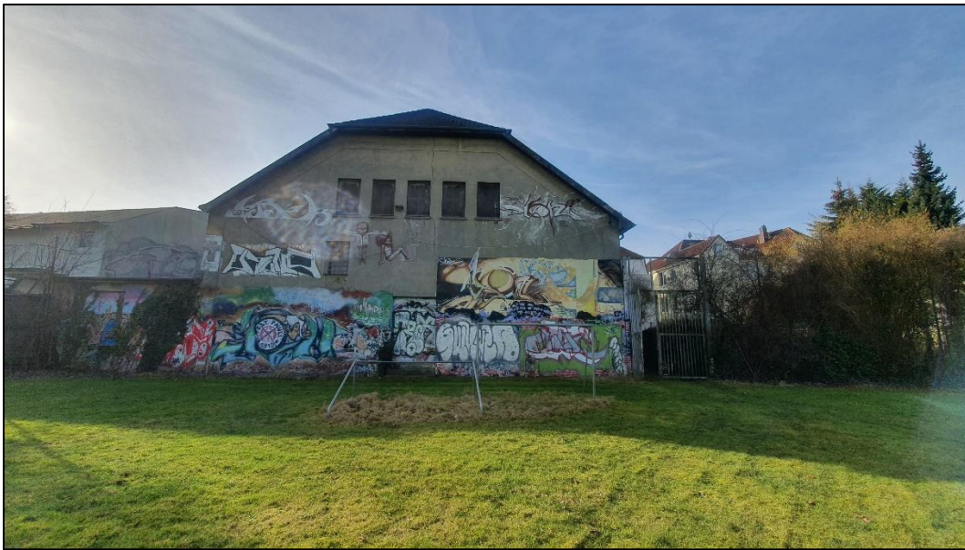
Abbildung 2: Jahnhalle, Rückseite (der Rundbunker befindet sich im Gebüsch, rechts im Bild)
