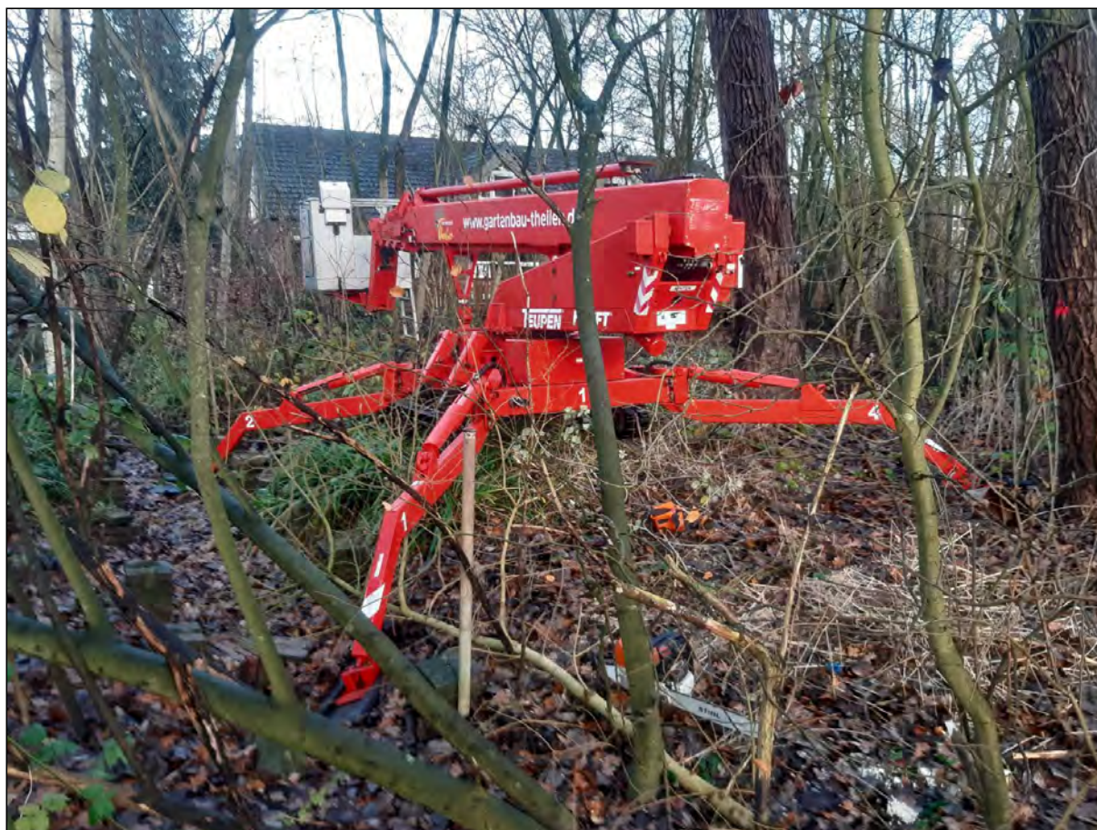
Abb. 6: Hubsteiger-Einsatz am 16. Dezember 2020
