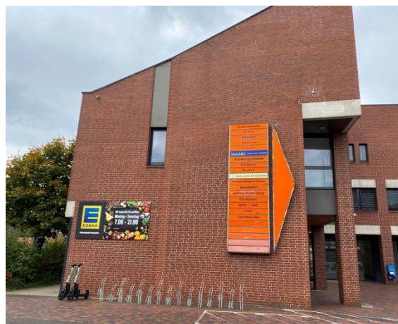
Foto 70: Geschlossenes Zentrum - Leerstände
