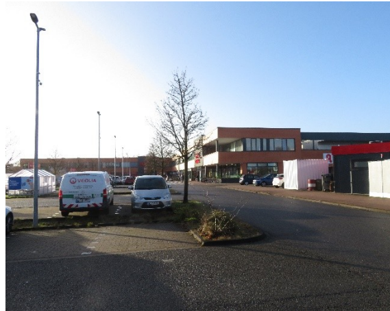
Foto 82: Ansprechender und gepflegter Zustand
