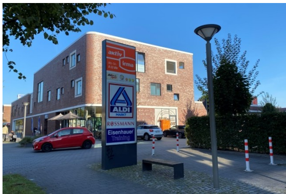
Foto 37: Nahversorgungsangebot im Neubau
