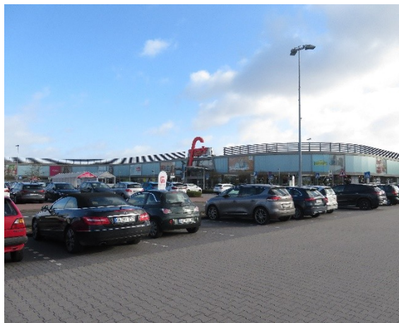
Foto 72: Fassadengestaltung des Shopping-Centers
