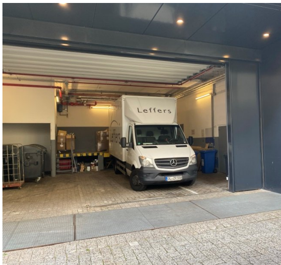
Foto 3: Hinterhofsituation durch Ladebereiche
