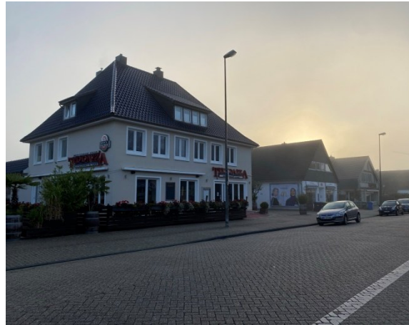
Foto 32: Fehlende bauliche Dichte
