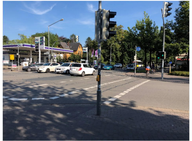
Ammerländer Heerstraße: Getrennter Geh- und Radweg, Einbindung des Radverkehrs in die Lichtsignalanlage
