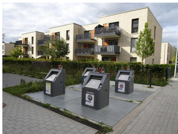
Abb. 26 Einsatz von Unterflurcontainer im städtischen Raum
